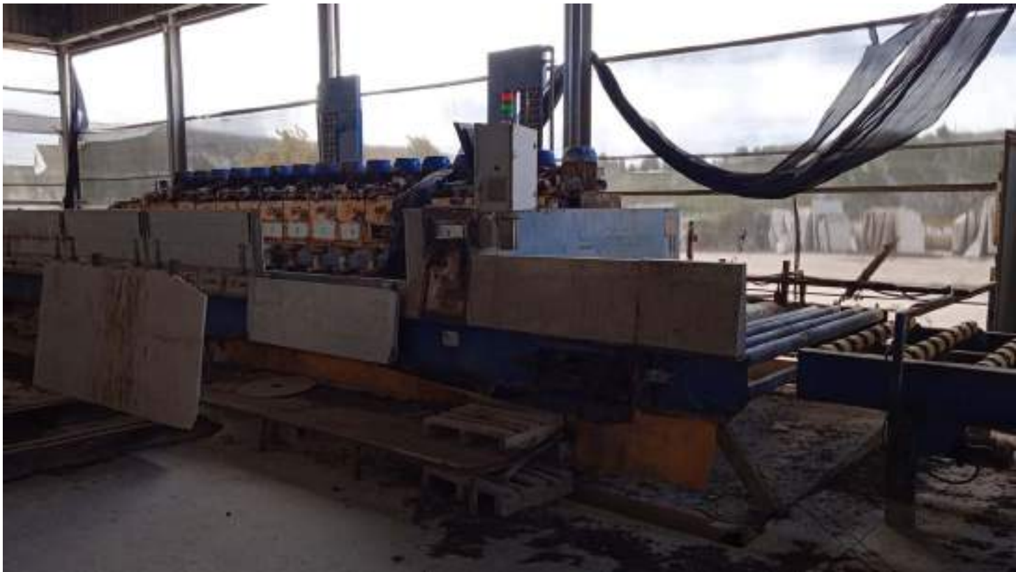
13. Impianto lucida lastre e quadri elettrici
